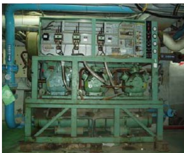
圖 4、老舊往復式冰水主機汰換為螺旋式冰水主機加裝變頻器泵浦
